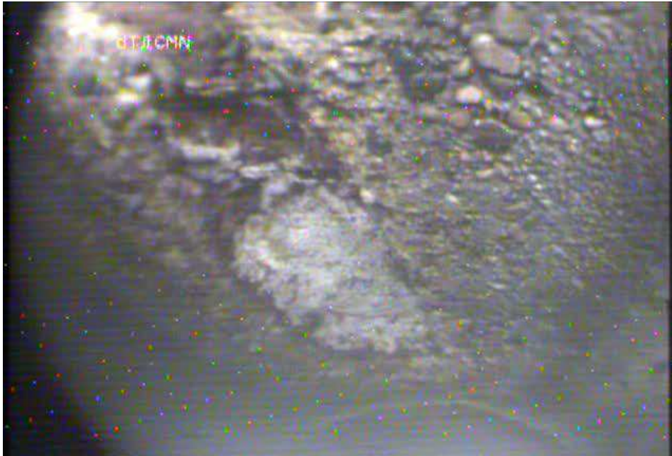
Отсутствует часть свода трубы, коррозия армирующих элементов. – Фото 6
